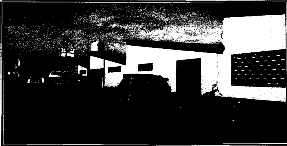
PINTADO DE MUROS EXTERIORES EN BLOQUE 3
